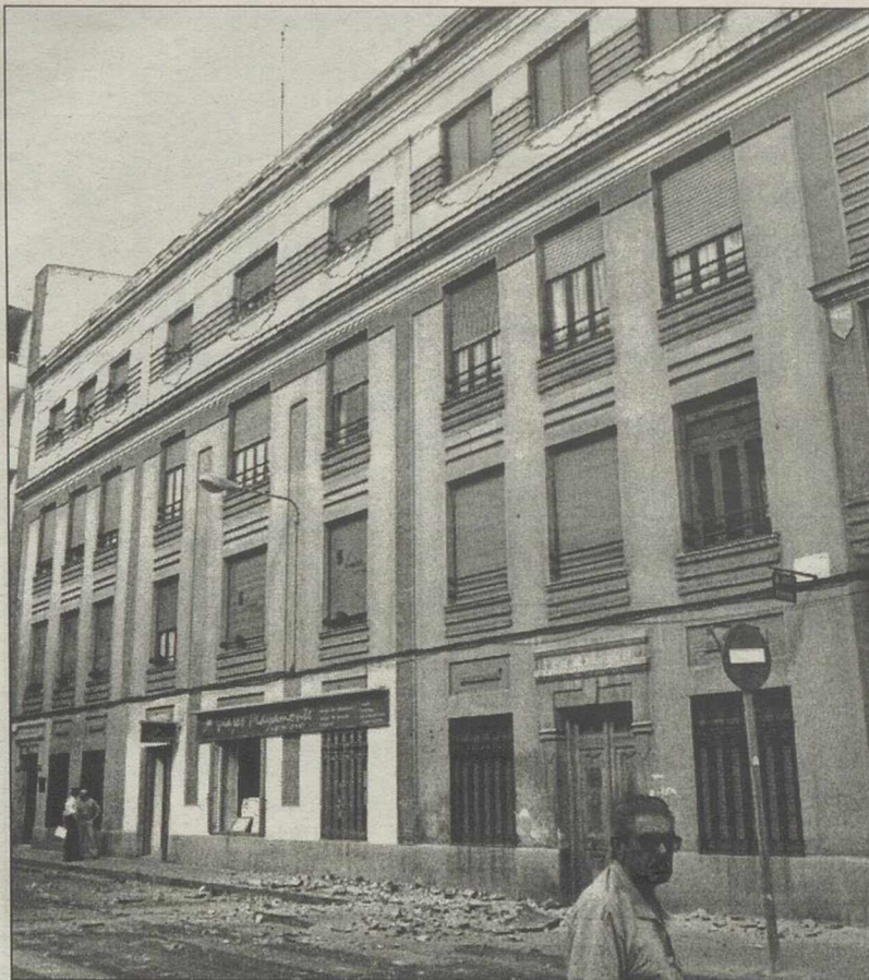
Los restos de la cornisa se estrellaron contra el suelo y tres vehículos T. F.
