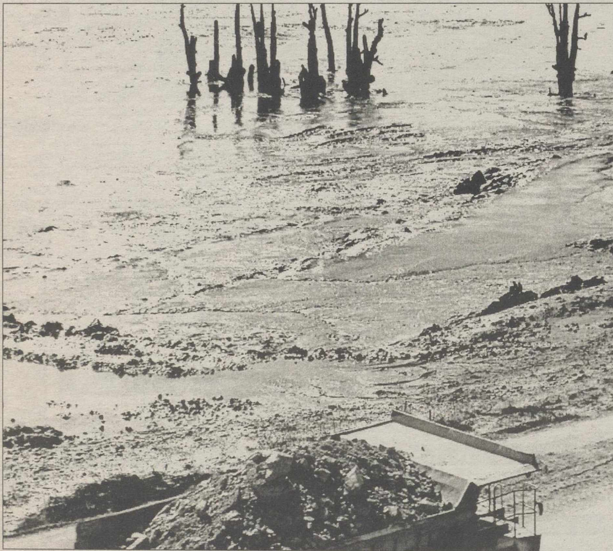
El vertido se produjo por la rotura de la balsa de agua y lodo tóxico de Minas de Aznalcóllar.
