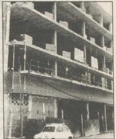
Unas viviendas en construcción.
