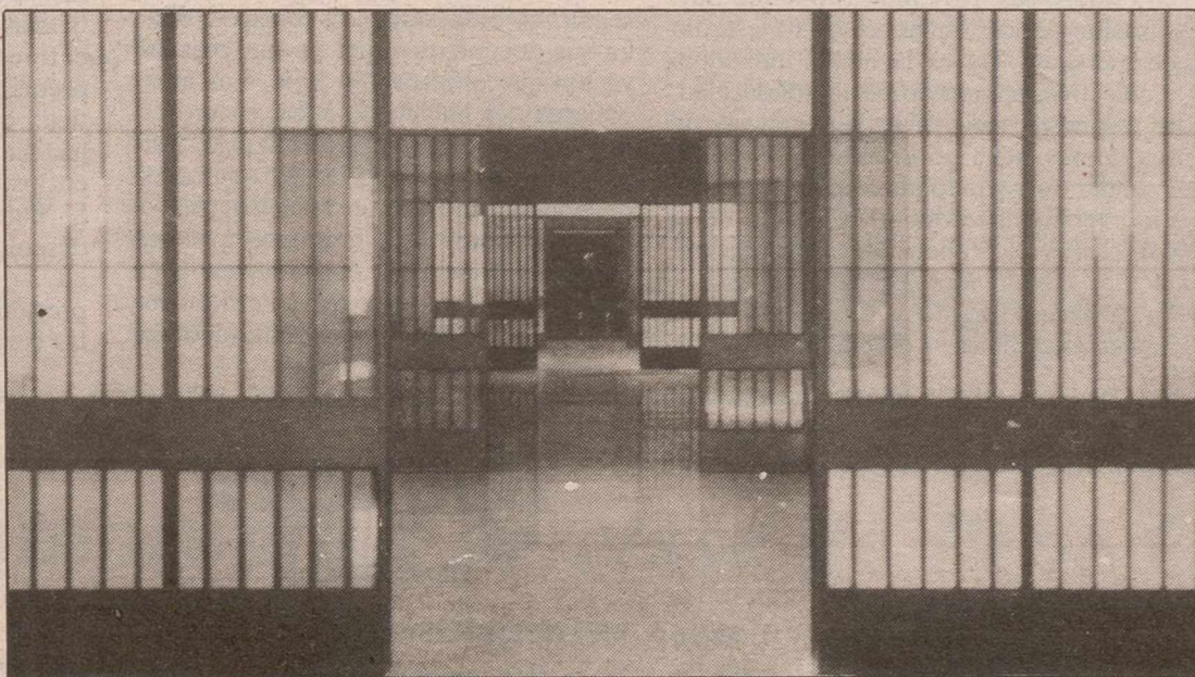
La cárcel de Alcázar de San Juan no reúne las condiciones de seguridad necesarias.
