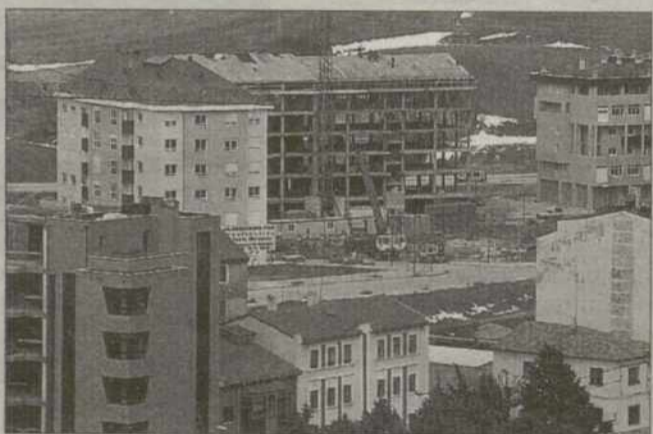
Construcción de viviendas en Burgos. / LUIS LÓPEZ ARAICO
