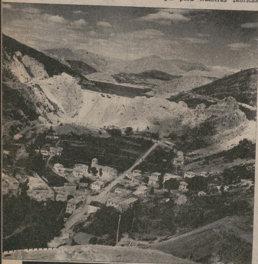
Bella perspectiva aérea de las instalaciones de la central hidroeléctrica de Los Barrios de Luna
