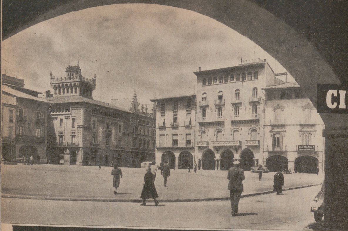
La plaza del Caudillo, inconfundible arquitectura que simboliza el espíritu de la ciudad de Vich
