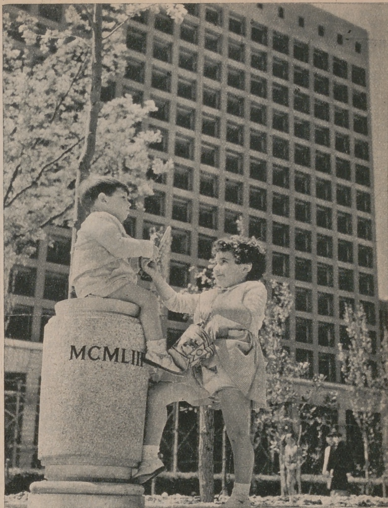
En el paseo del Prado —en trance de reforma y embellecimiento— juegan los niños. Al fondo, el edificio que se construye para sede de la Organización Sindical española.
