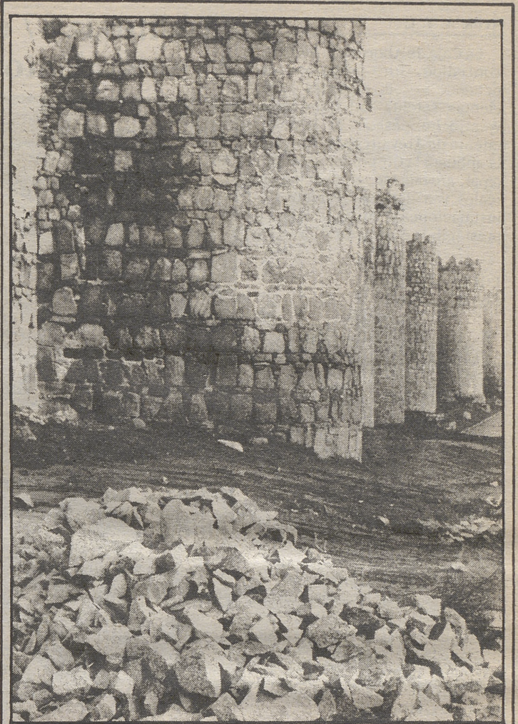
Las obras han quedado paralizadas hasta que mejoren las temperaturas. LUMBRERAS
