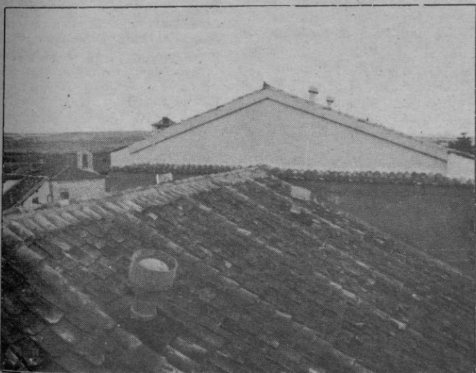
Un detalle de la nueva cubierta del Juan Bravo
