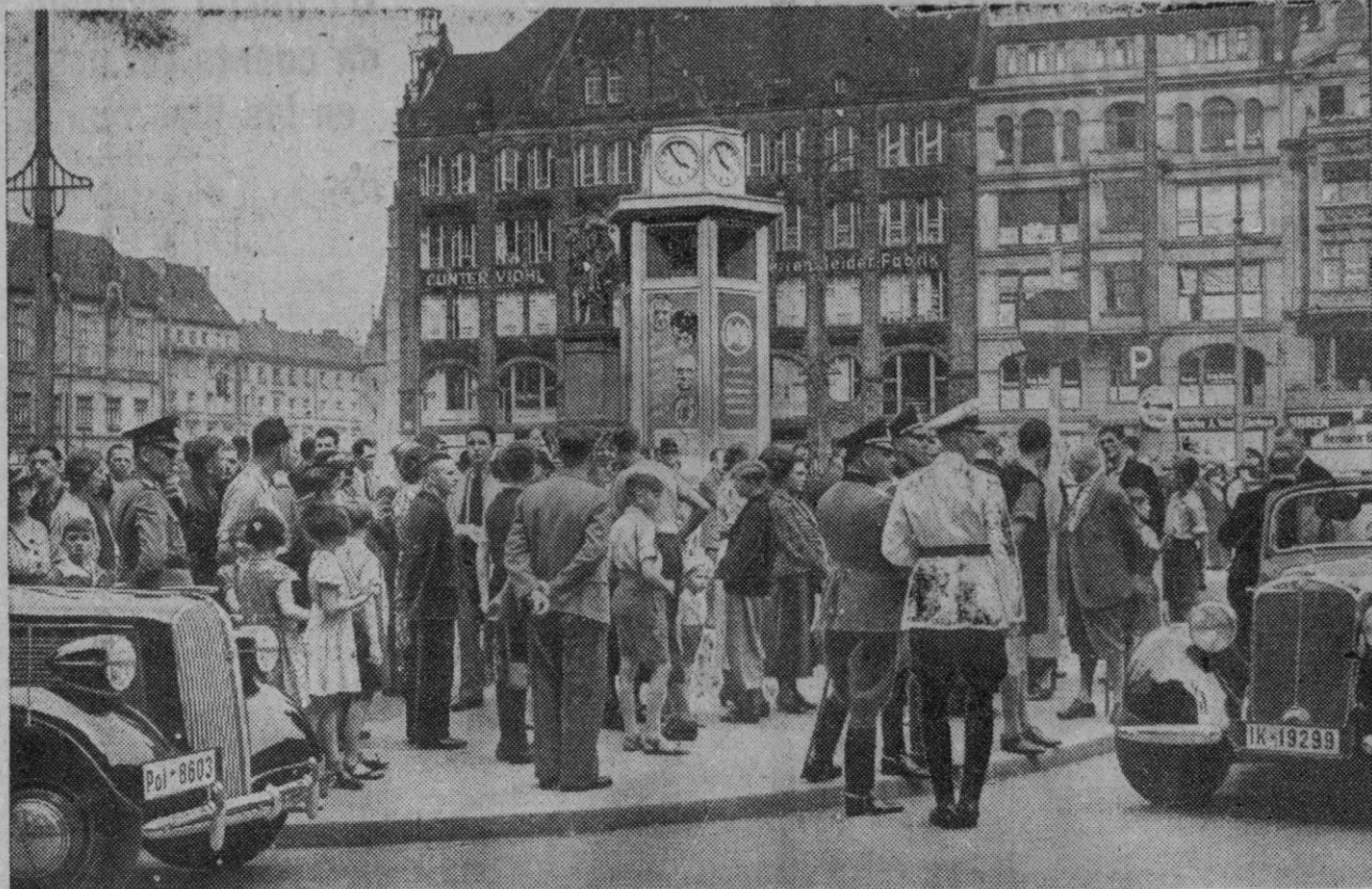
La fotografía corresponde a un lugar de la ciudad de Breslau, en el que se encuentra congregado el público para oír la palabra de las autoridades que tomaron parte en el acto inaugural de las distintas instalaciones
