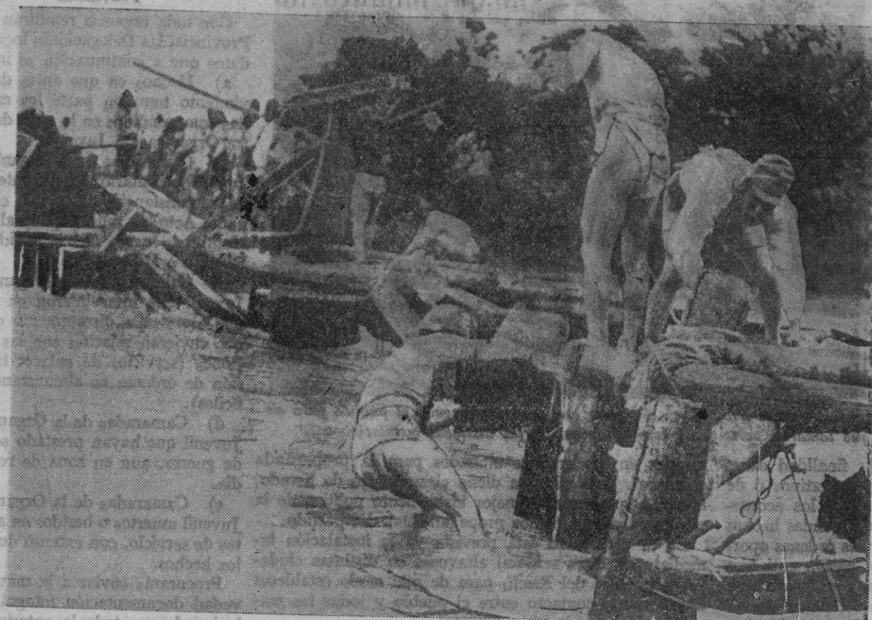
Cuando los chinos volaron los diques del río Amarillo originando devastadoras inundaciones, se impuso un alto en las operaciones japonesas. En la foto aparecen soldados de Ingenieros, nipones, reconstruyendo un puente que fué arrastrado por las aguas
