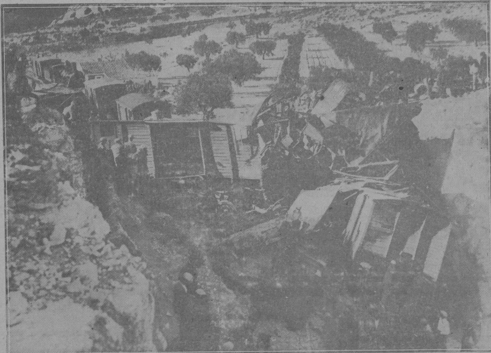
Fuente la Higuera (Valencia): Estado en que quedaron los coches del tren de mercancías que chocaron contra unos vagones que había en la vía muerta
