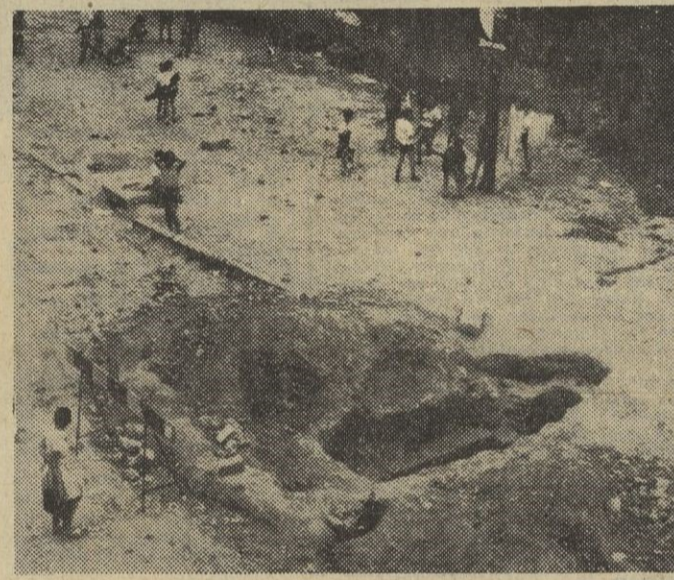
Este es uno de los pozos que reventó al no poder soportar la presión del agua que conducía el colector
