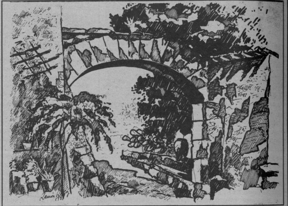
1.º—Arc d'entrada en el recinte de les antigues cases de la possessió de COLONYA (Pollença). Avui sols es veuen ruïnes de la part que devia tancar la clastra.
