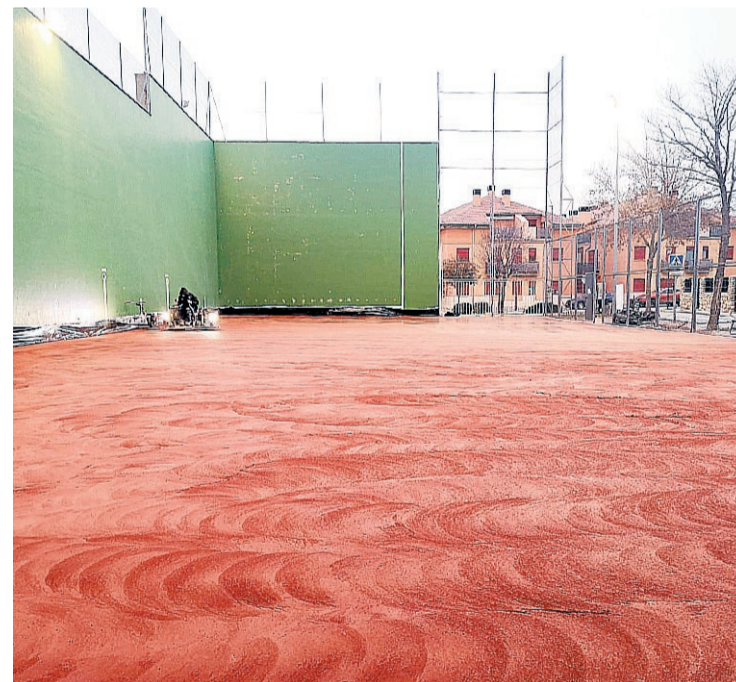
El frontón municipal durante estos días de ejecución de trabajos. A. PINELA
