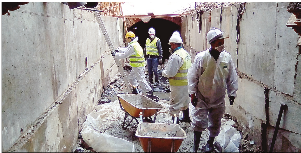
Trabajos de reparación en la bóveda del Clamores./EL ADELANTADO
