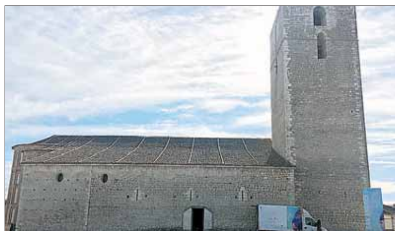
Iglesia de San Andrés en el proceso de desmontaje./ C.N.
