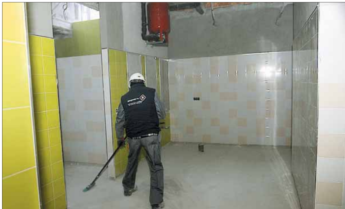
Tras reanudar la obra el día 15 de diciembre, la empresa realizó trabajos de alicatado y solado en el pabellón. / KAMARERO
