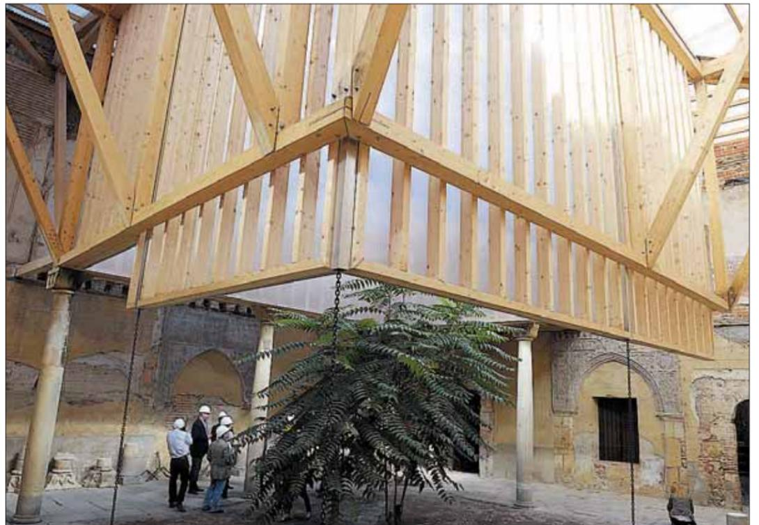
Las obras de consolidación incluyeron la estabilización de los muros a través de una estructura de madera. / KAMARERO
