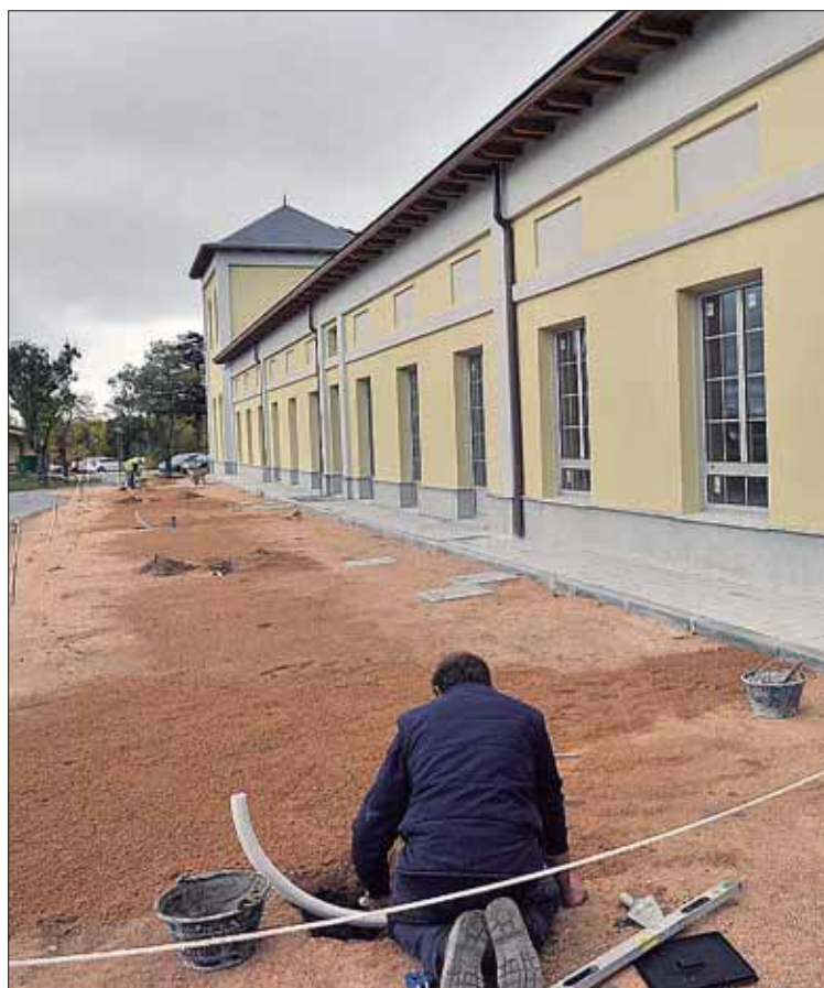
Estado actual de las obras de La Faisanera. / KAMARERO
