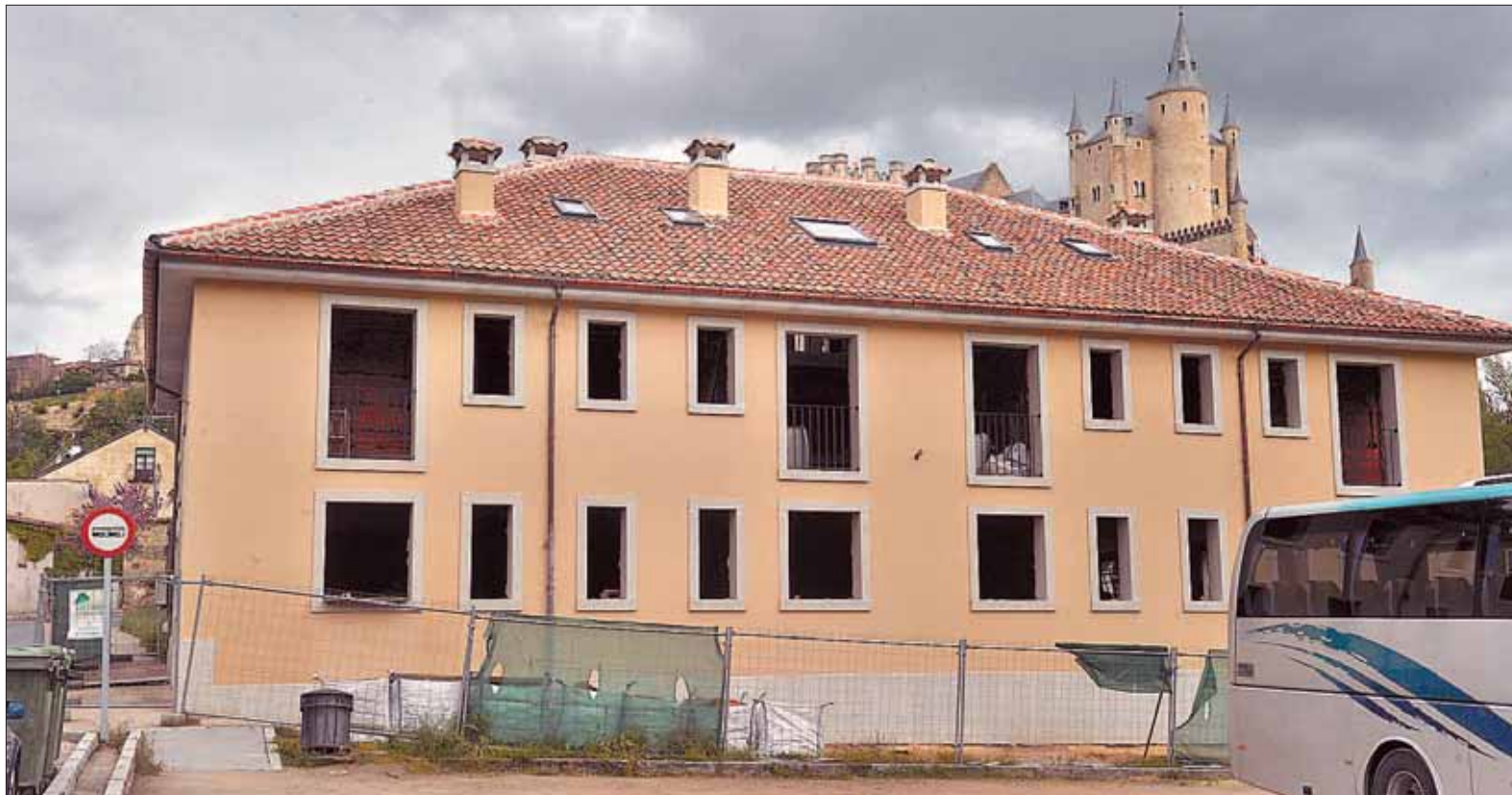
Las obras de construcción del polémico edificio de San Marcos se encuentran ya en una fase muy avanzada. / KAMARERO
