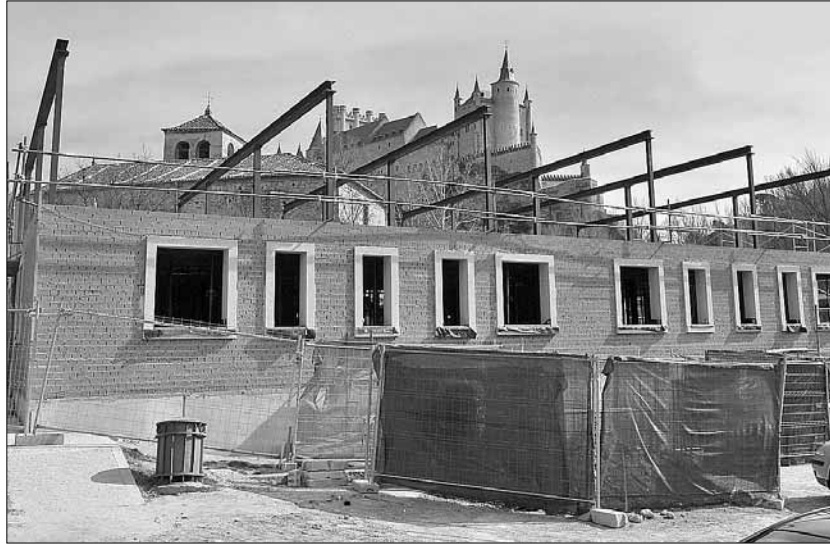
Edificio en construcción en el barrio de San Marcos, a los pies de la ciudad histórica y del Alcázar. / KAMARERO
