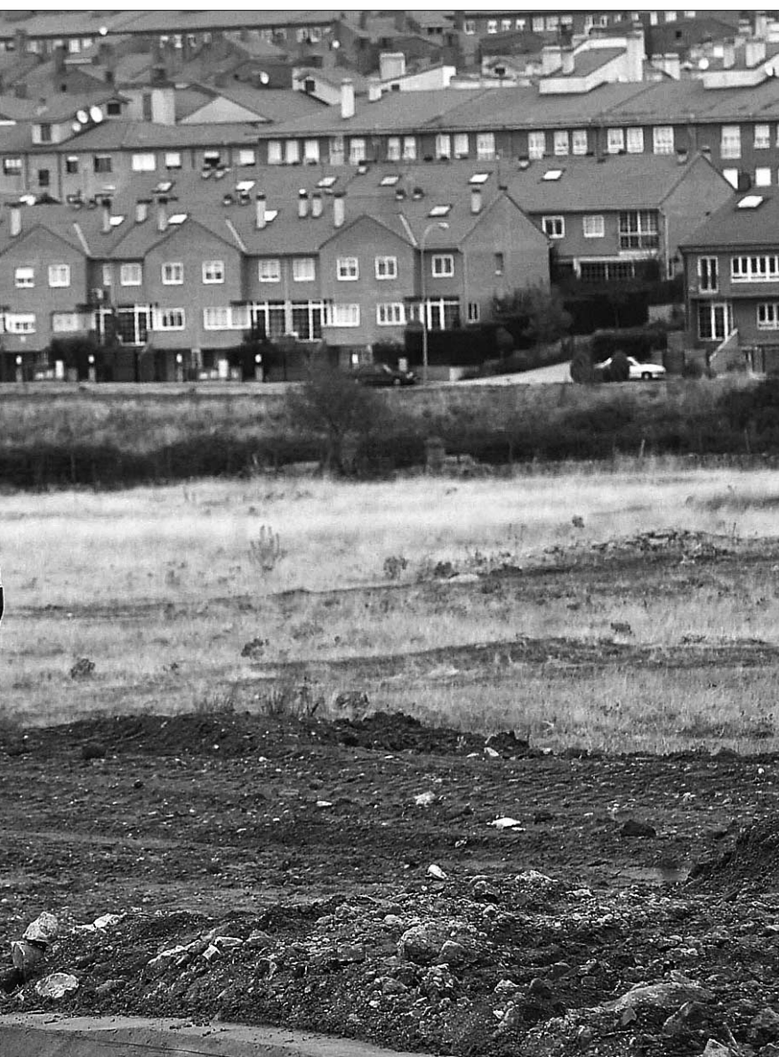
del nuevo vial de la estación del AVE, frente a Nueva Segovia. / JUAN MARTÍN
