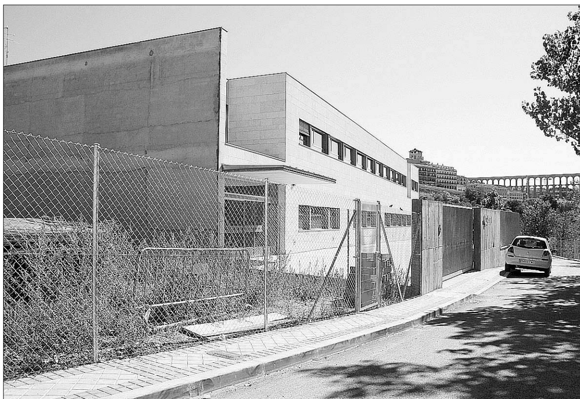
Los trabajos de asfaltado del acceso al nuevo centro de salud se están desarrollando esta semana./FERNANDO PEÑALOSA
