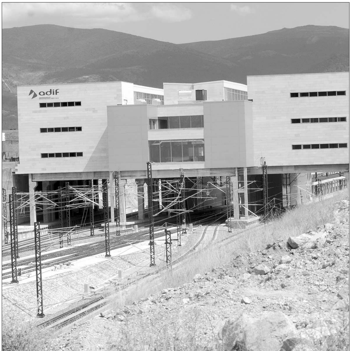
Las obras en la estación del TAV están prácticamente acabadas, a falta de algunos detalles./KAMARERO
