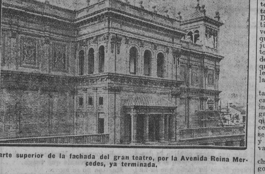
Parte superior de la fachada del gran teatro, por la Avenida Reina Mercedes, ya terminada.
