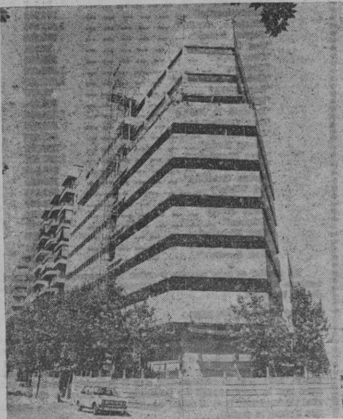
Avanzadísima ya las obras de construcción puede ya apreciarse y comentarse la estética del nuevo edificio para la Jefatura Superior de Seguridad y Policía Nacional.
