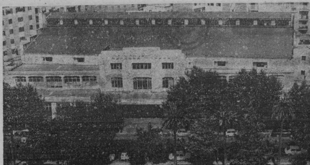
Una foto para la historia. Panorámica del cerrado «Frontón Balear» que en poco tiempo también será demolido para dar lugar a la construcción de un centenar largo de viviendas y plantas bajas comerciales. — (Fotos Cosme Vives).
