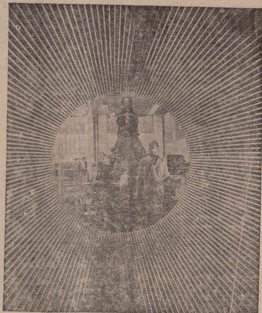
**MOTOR LUNAR.**—Los técnicos montan un motor F-1 en la fábrica que la North American tiene en Canoga, California. El motor está calculado para generar un empuje de 680.000 kilogramos. Un racimo de cinco motores F-1 integrará la primera fase del cohete Saturno V que se proyecta usar en el programa norteamericano Apolo de vuelo tripulado a la Luna. Esta fotografía ha sido tomada a través de una tobera de empuje del motor F-1.
