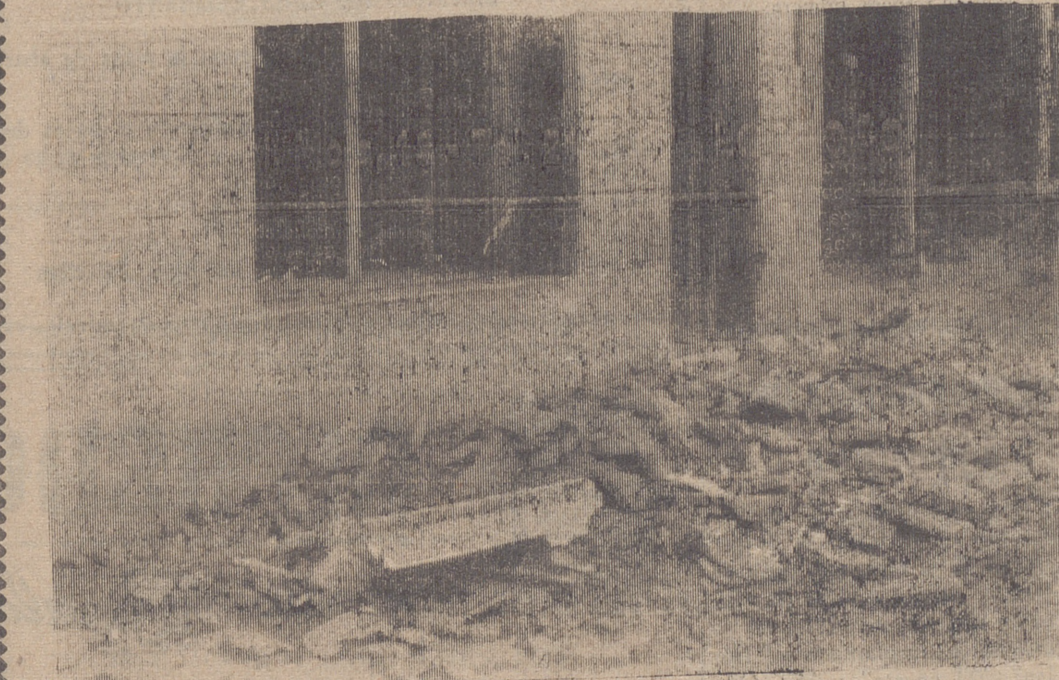
Escombros que han ocasionado a los dos hombres. — (Foto Sánchez)
