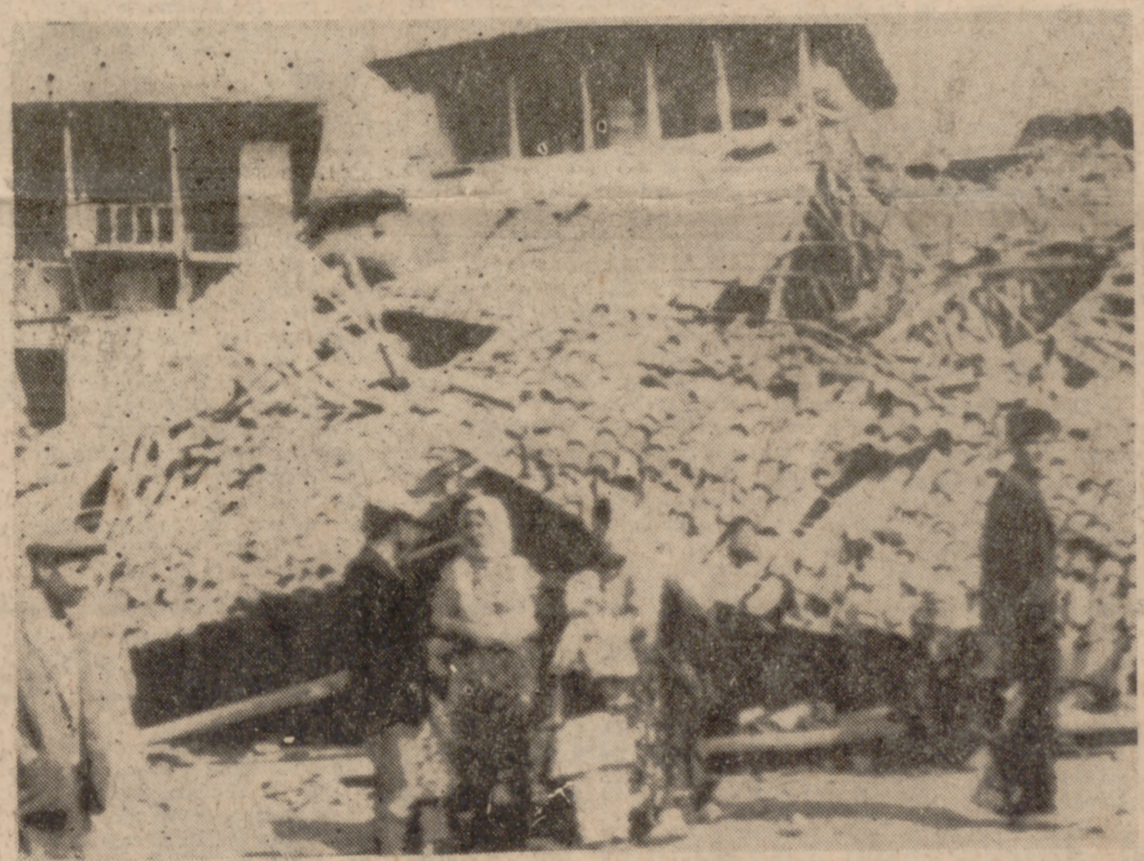
ALASEHIR (Anatolia).—Casas derrumbadas a causa del temblor de tierra registrado en esta zona del oeste de Anatolia.—(Telefoto Upi-Cifra.)
