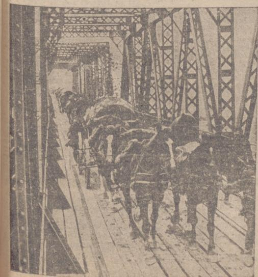
Con tablas de madera arreglan los zapadores alemanes los puentes ferroviarios en Rusia para que puedan ser utilizados para todos los fines del Ejército alemán
