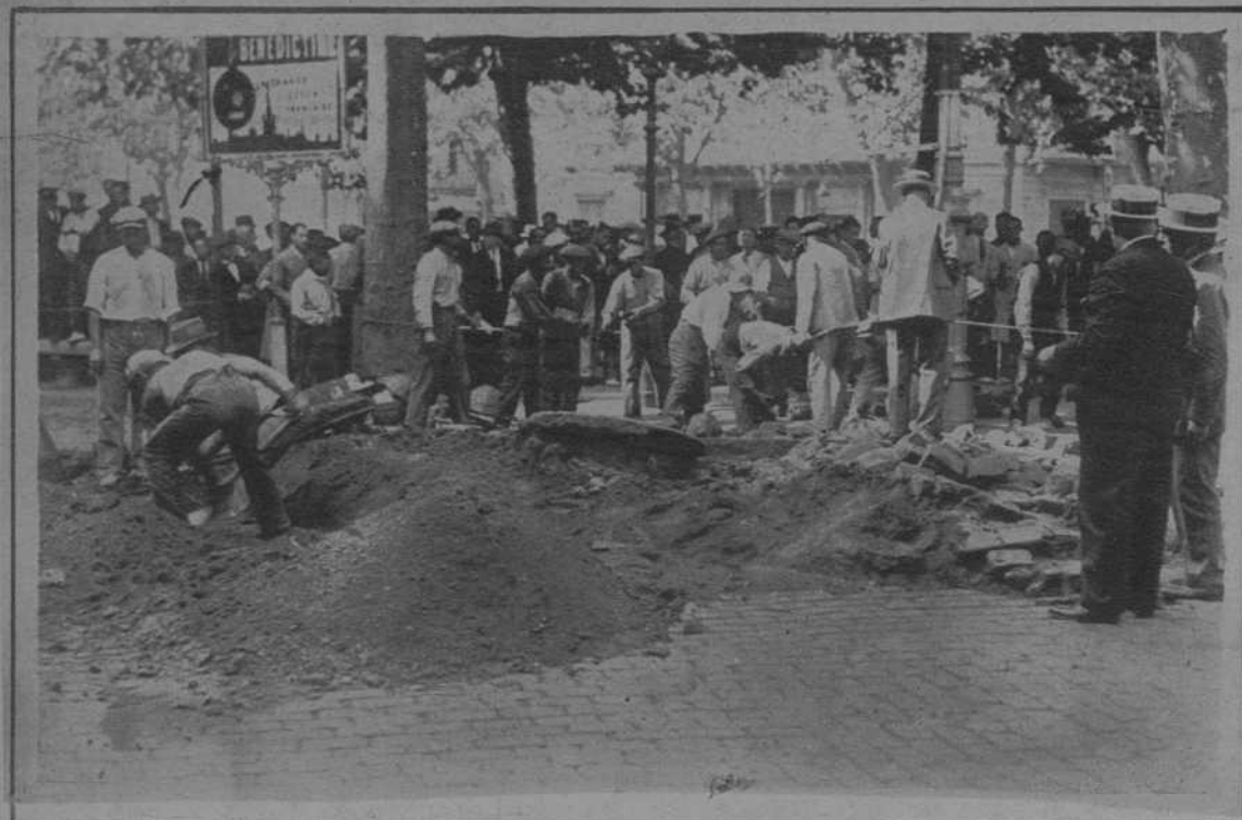
Trabajos de reparación de los raíles del tranvía, levantados en una extensión considerable. — (Fots. Badosa)
