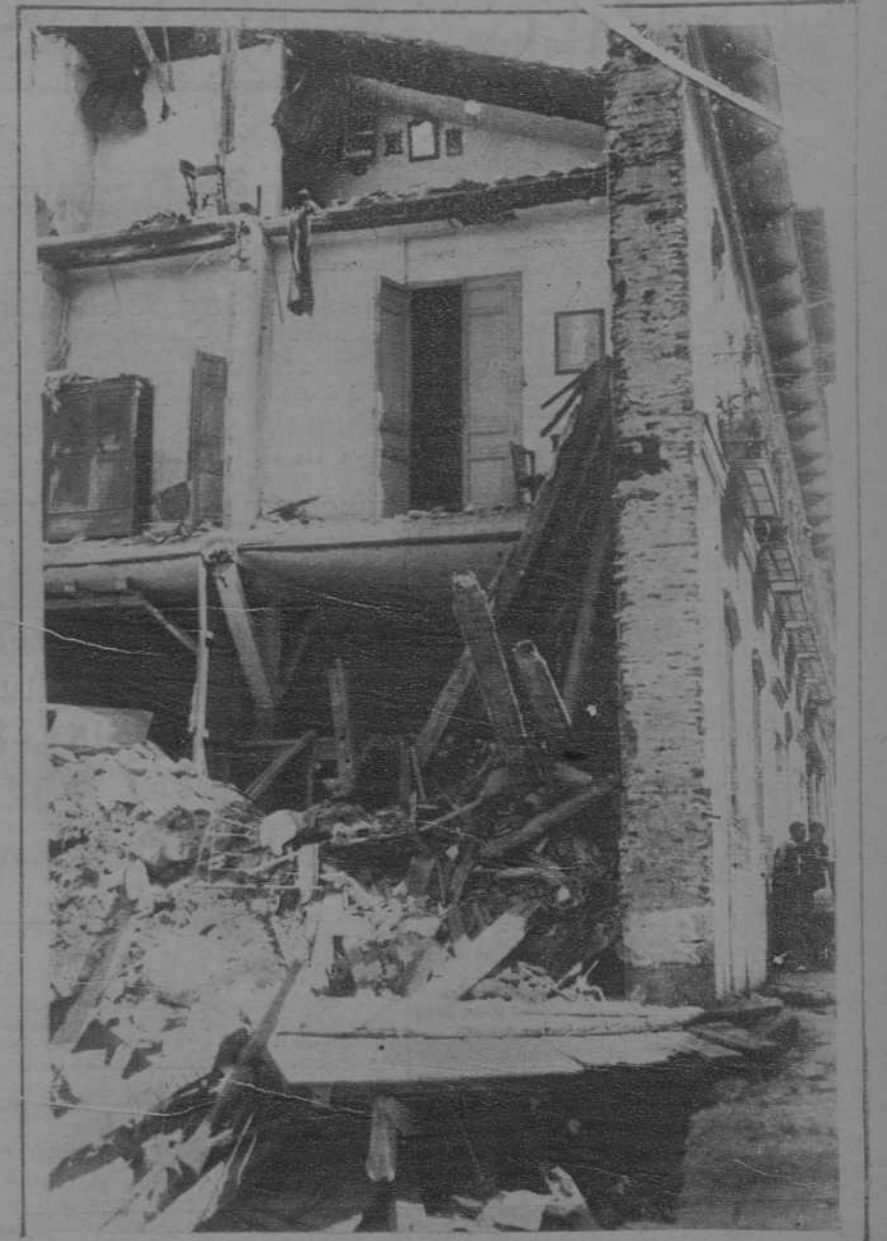
Madrid.—Estado en que quedó la casa que se derrumbó en la calle del Doctor Duquet, a consecuencia de cuyo siniestro resultaron tres heridos graves.—(Fot. Piortiz)
