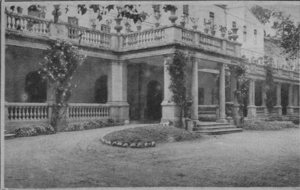
Entrada principal al edificio
