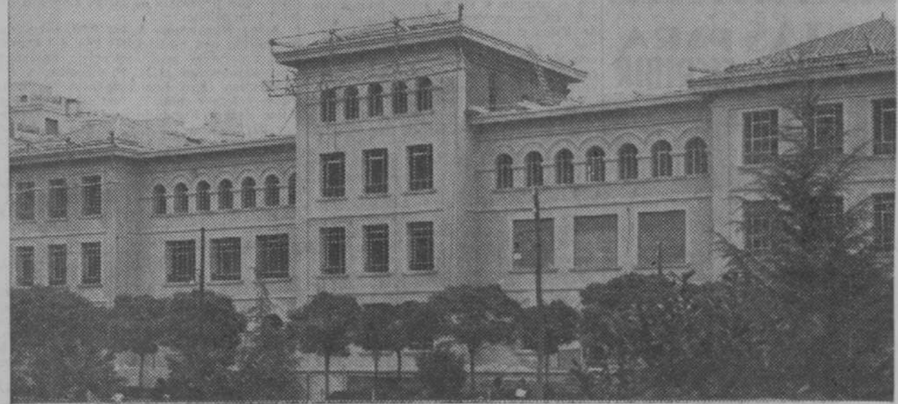
(Arriba) "Chalet" económico construido por la Casa Agromán, S. A. (Abajo) Uno de los grupos escolares inaugurados ayer y que, como todos los construidos en Madrid, está dotado de ventanas metálicas HOPE
