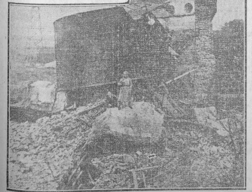
Depósito de agua demolido.
