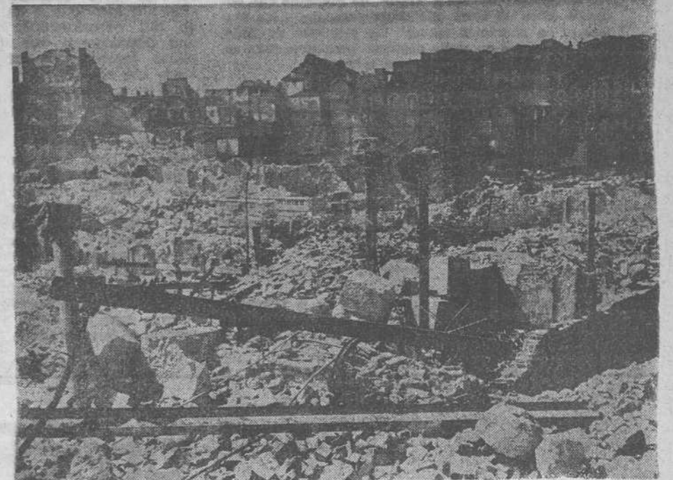
El centro de la ciudad, convertido en un montón de escombros humeantes. (Foto del archivo Samot.)
