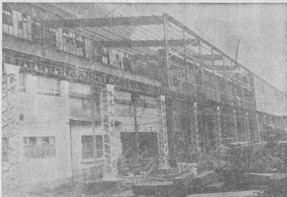
Prensa 6.300/7.500 Tns. — Nave para sala de bombas.
