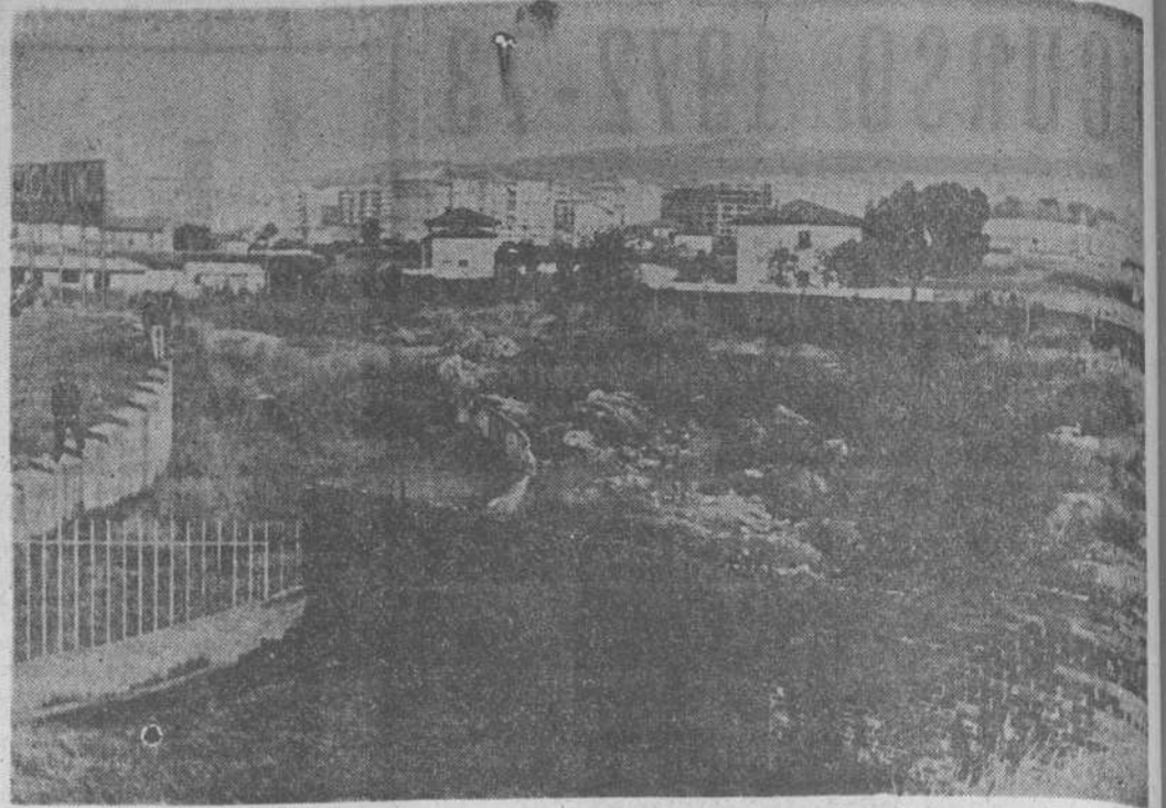
Aquí se construirá el campo de fútbol para juveniles. En la parte de atrás de la grada sur del Malecón, al fondo, las casetas que ya están casi terminadas. (FOTO LOBETO)
