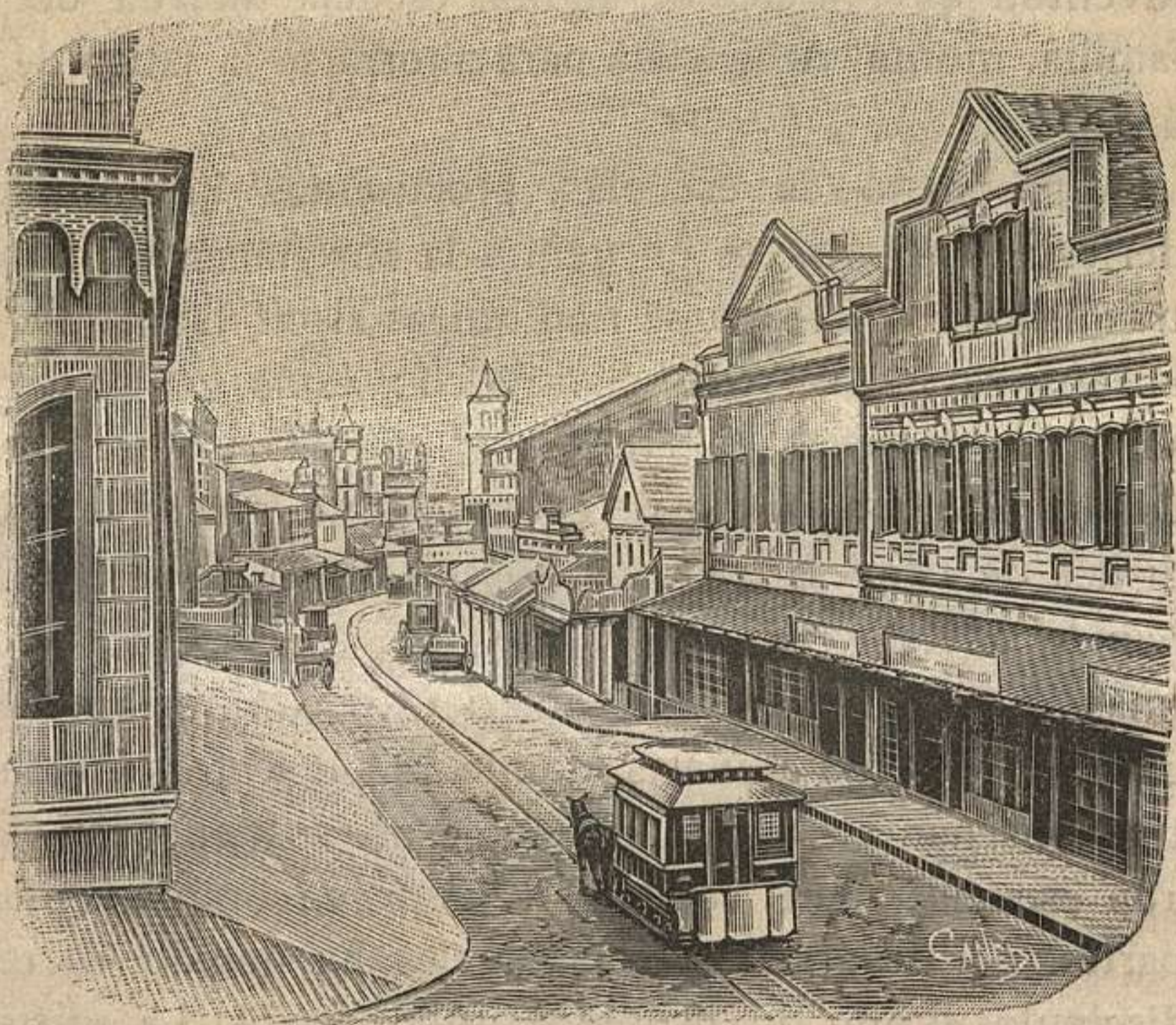
Calle del Fuerte, la principal de Honolulu. (De una fotografía.)
