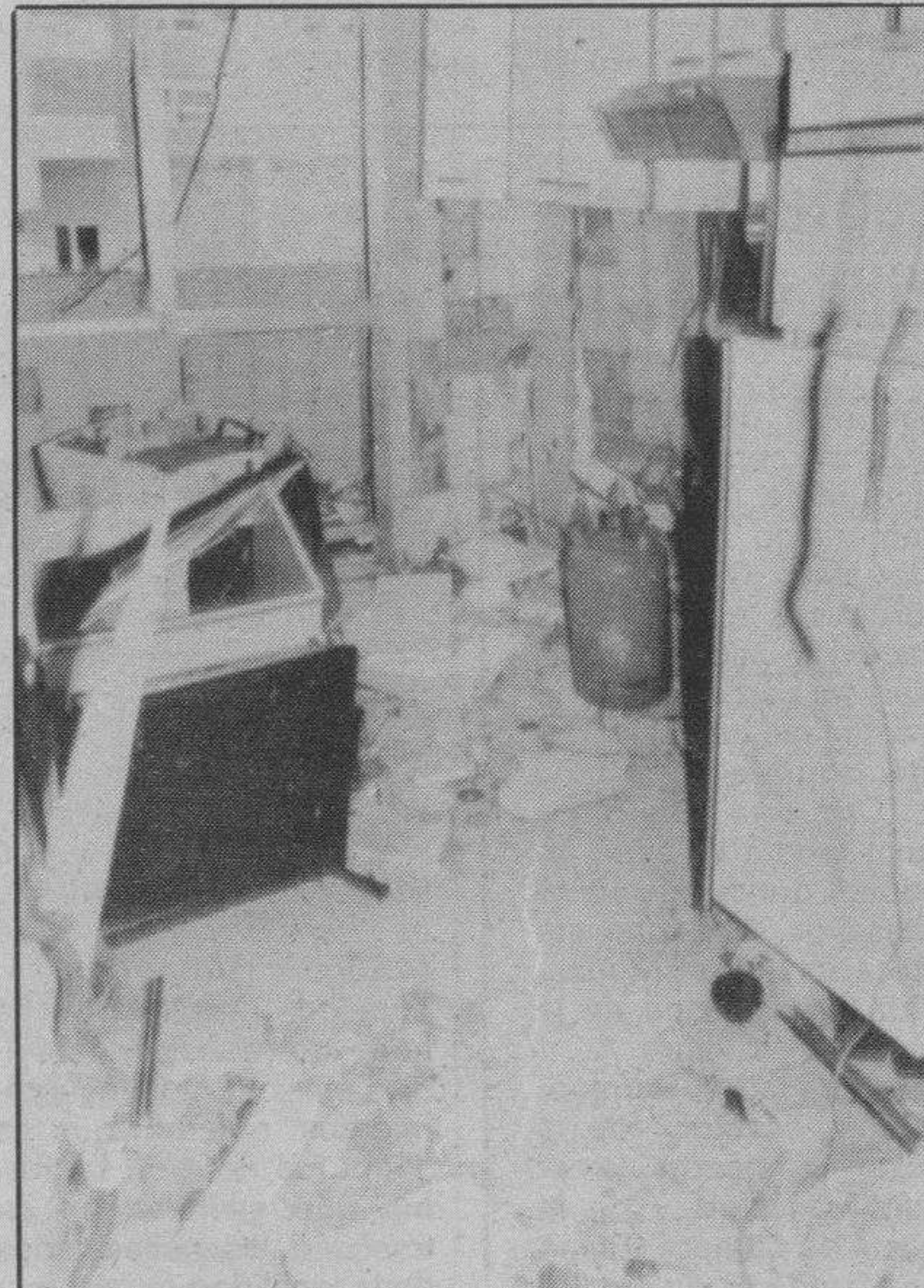
Estado en que quedó la cocina. Efe
