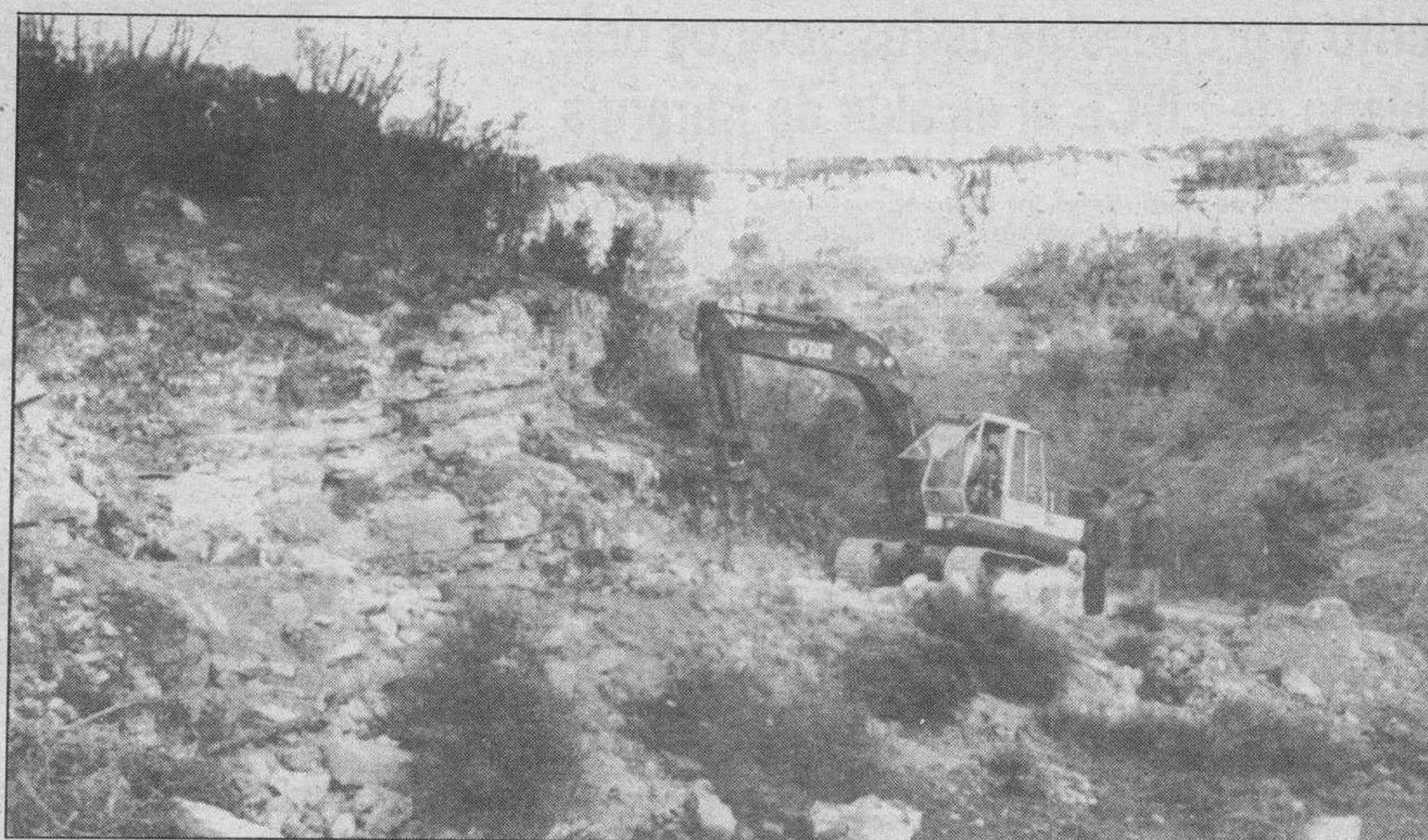
La llamada «curva del oleoducto» en la carretera San Felices-Sargentos.
