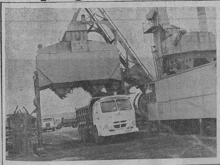
Hacen falta 100.000 m³ de áridos para la construcción de una autopista. Los Pegaso 3.060 L, de 200 cv, los transportan.
