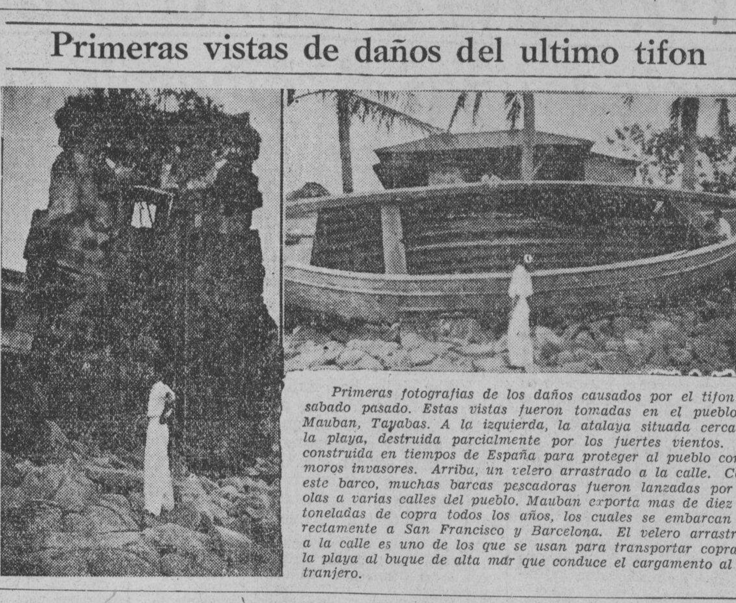
Primeras vistas de daños del ultimo tifon Primeras fotografías de los daños causados por el tifón del sábado pasado. Estas vistas fueron tomadas en el pueblo de Mauban, Tayabas. A la izquierda, la aldea situada cerca de la playa, destruida parcialmente por los fuertes vientos. Fue construida en tiempos de España por los fuertes vientos. Fue moros invasores. Arriba, un velero arrastrado al pueblo contra este bacio, muchas bacas pescadoras fueron lanzadas por las olas a varias calles del pueblo. Mauban exporta mas de diez mil toneladas de copra todos los años, los cuales se embarcan directamente a San Francisco y Barcelona. El velero arrastrado a la calle es uno de los que se usan para transportar copra de la playa al buque de alta mar que conduce el cargamento al extranjero.
