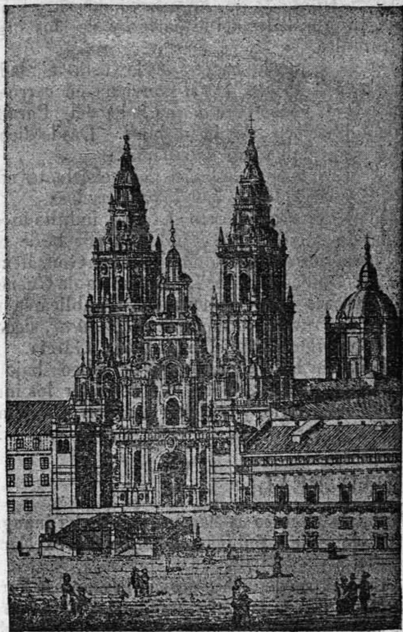
SANTIAGO DE GALICIA— Fachada principal de la Catedral
