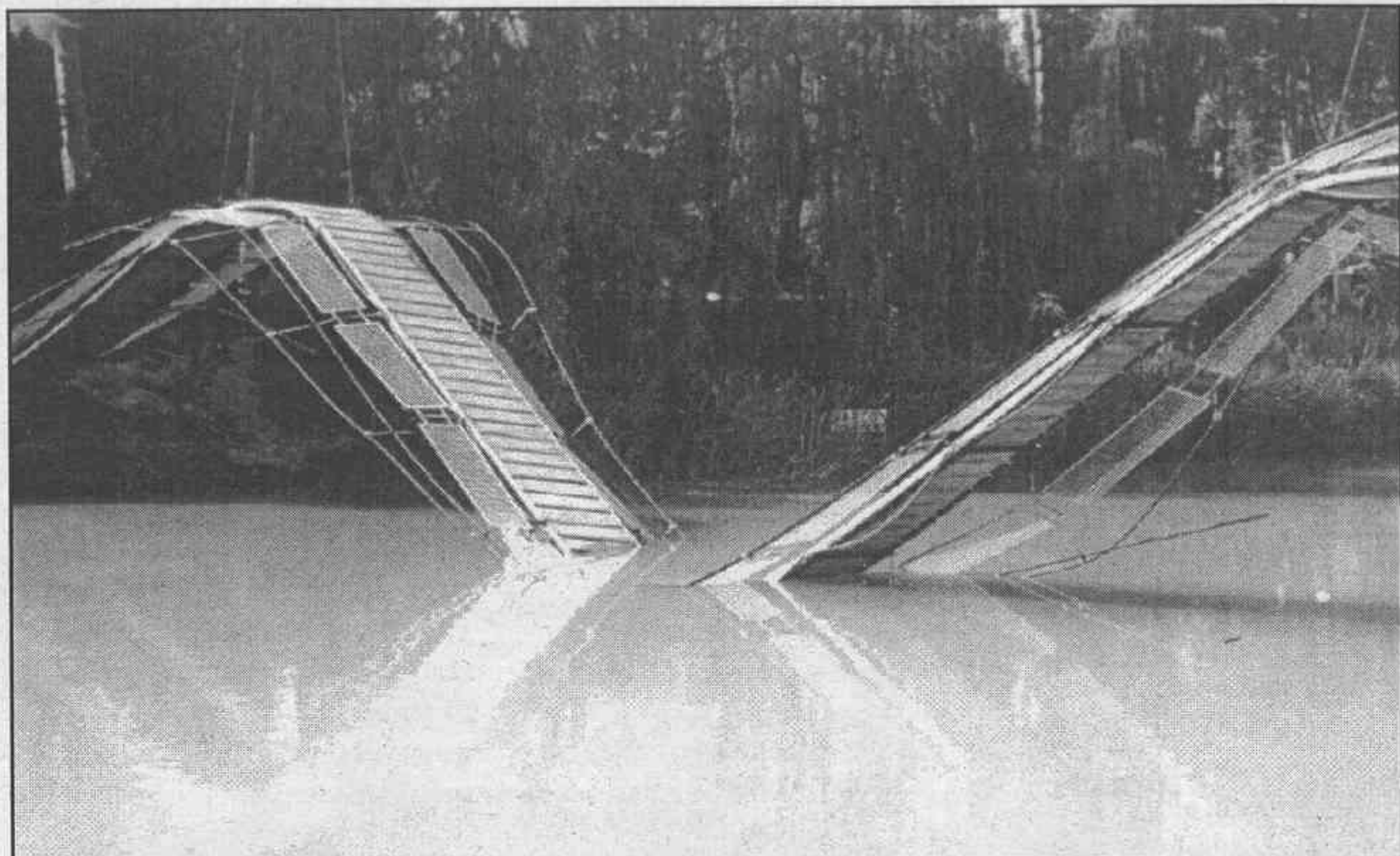
Así quedó el puente colgante después del incidente
