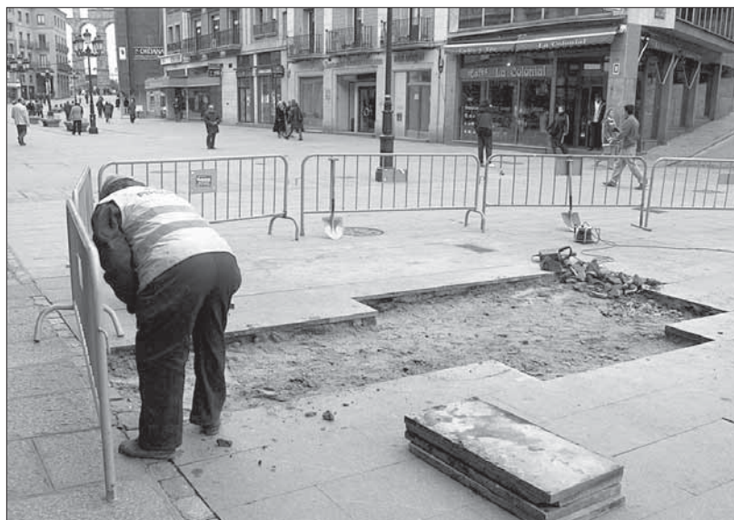
Un operario retira las losas actuales, que serán sustituidas por otras más gruesas
