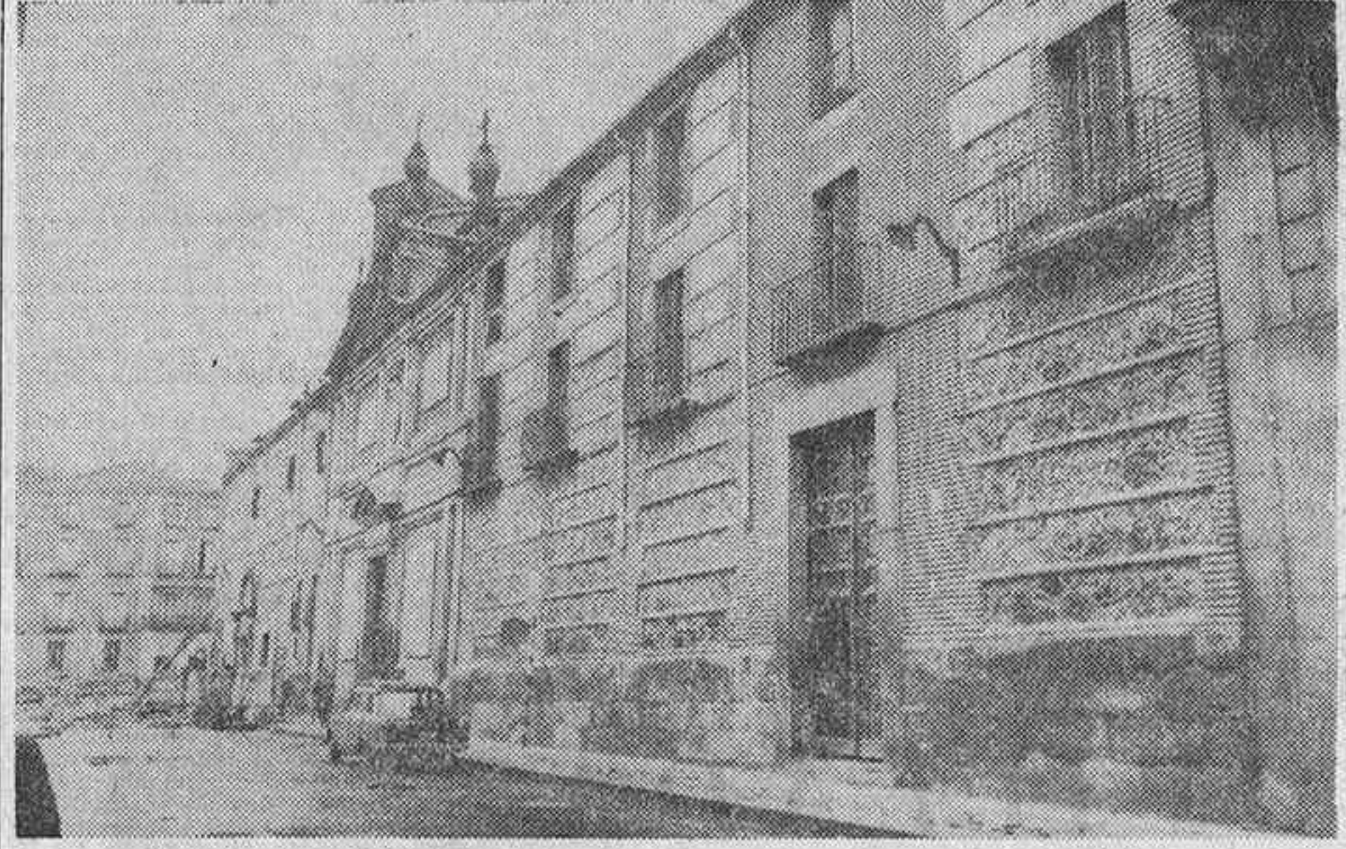
Parte delantera del monasterio-convento, donde han comenzado a montarse unos andamios para los necesarios trabajos.
