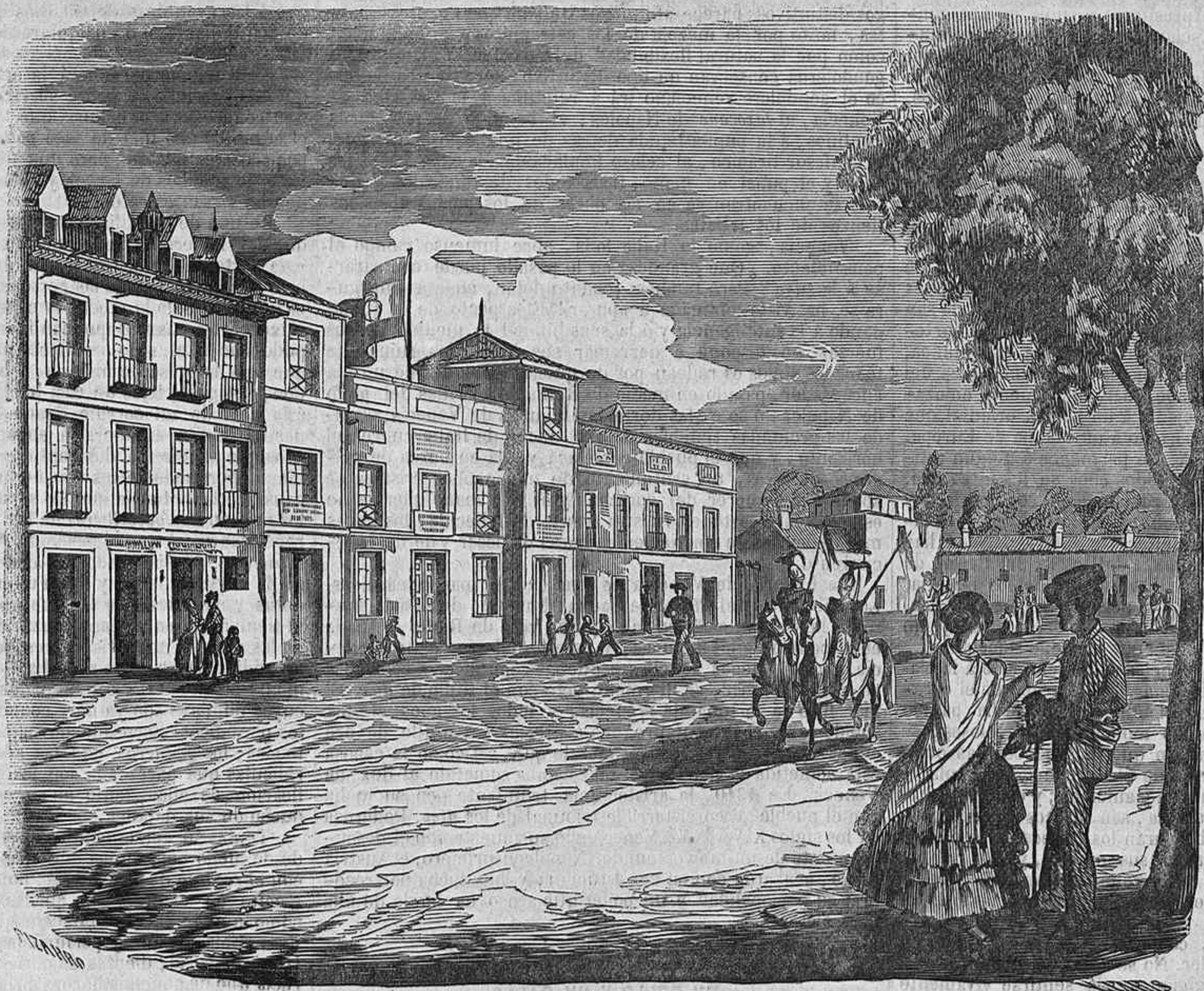
Vista de la Plaza Mayor de Chamberí.
