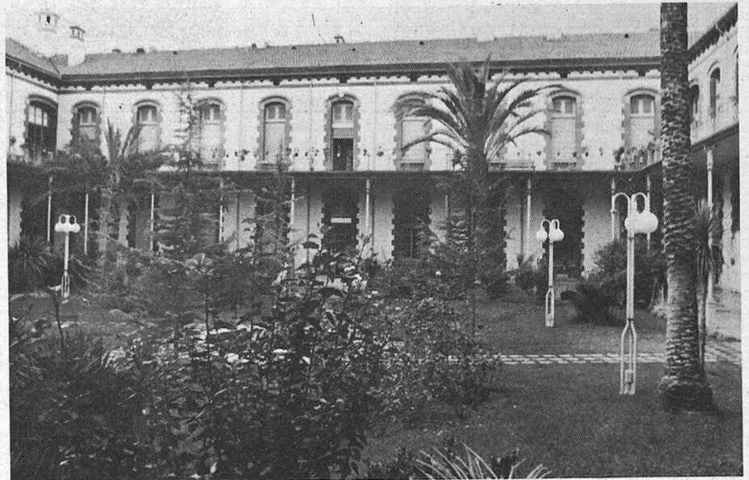
El Hospital, uno de los centros donde la Diputación está invirtiendo mayor capital.
