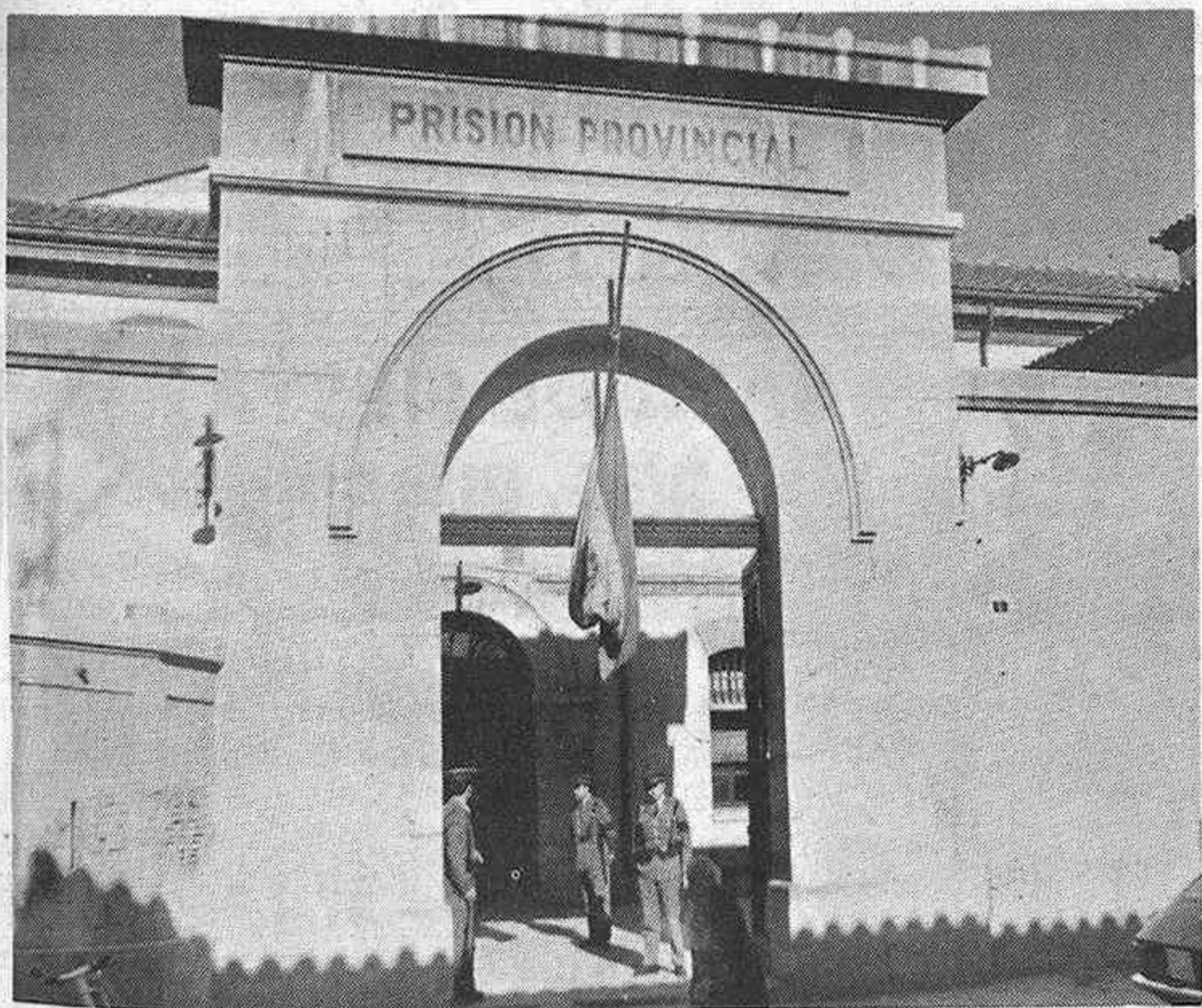
En la foto de archivo, la actual Prisión Provincial. Ayer el Consejo de Ministros aprobó la construcción de un nuevo edificio en el que albergar a los delincuentes en nuestra provincia.
