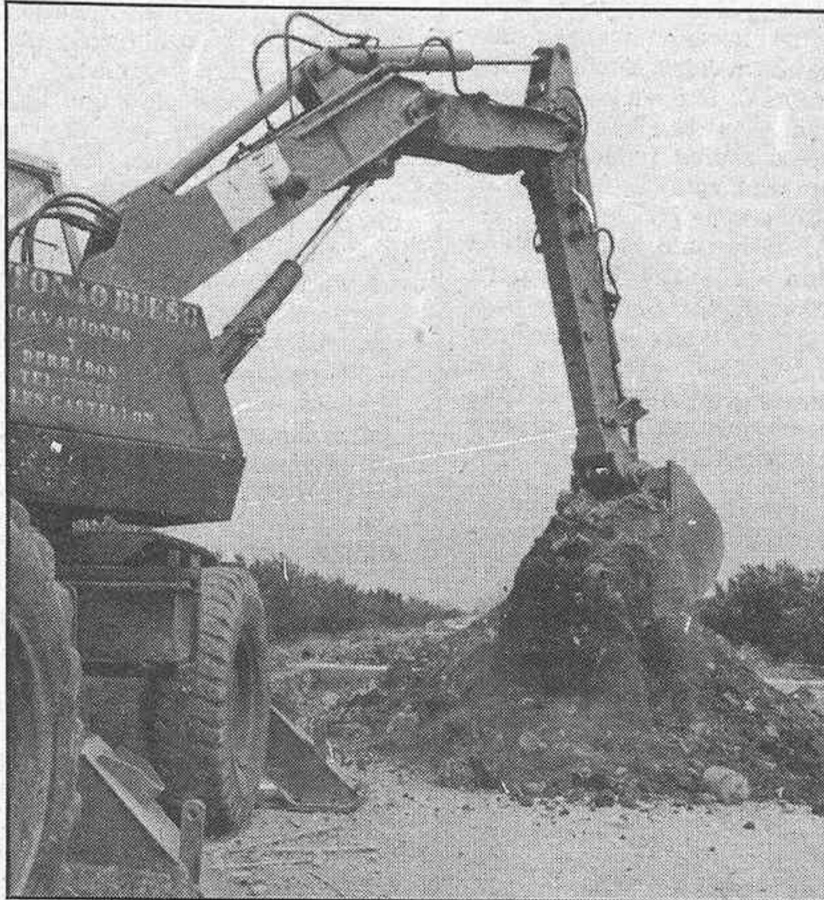
Una zanja de 4 kilómetros albergará la tubería / PEDRO GUERRERO
