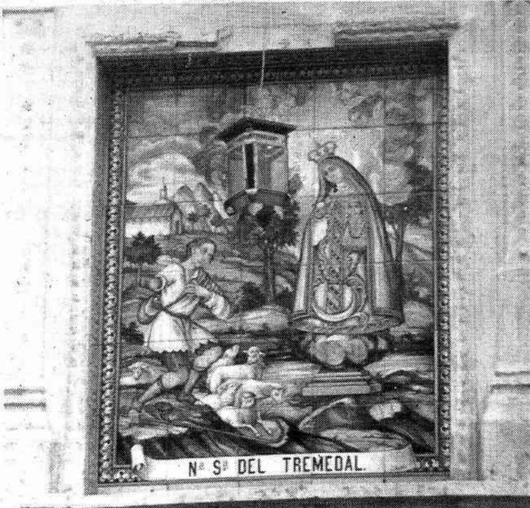
El retablo de la calle Tremedal uno de los más significativos de la localidad podría desaparecer en breve, de ser derruida la fachada donde se halla emplazado.
