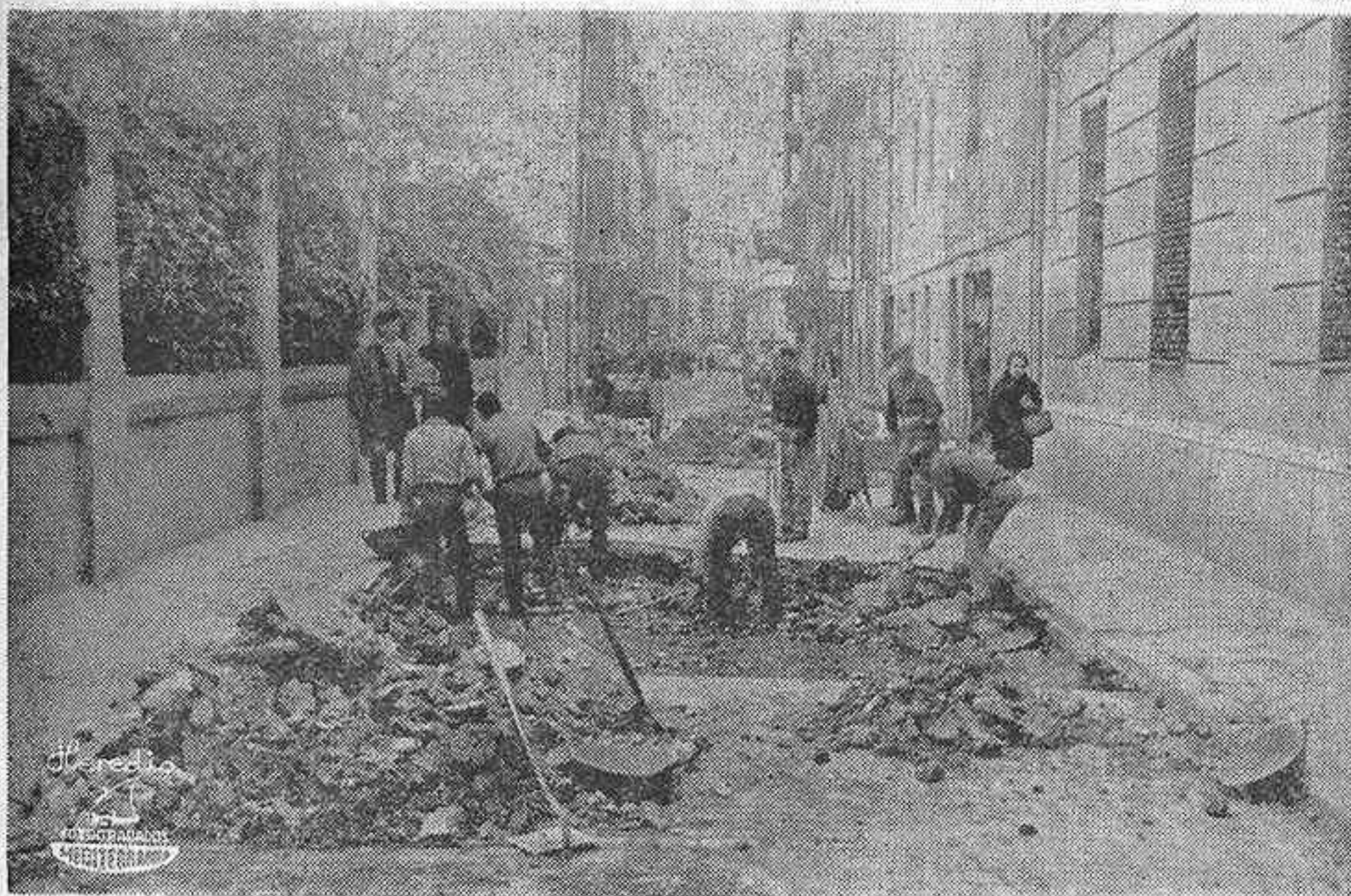
Estos días hay trabajos de arreglos en nuestras calles, por arriba y por abajo.
